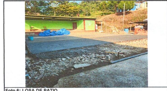
Foto 6: LOSA DE PATIO
