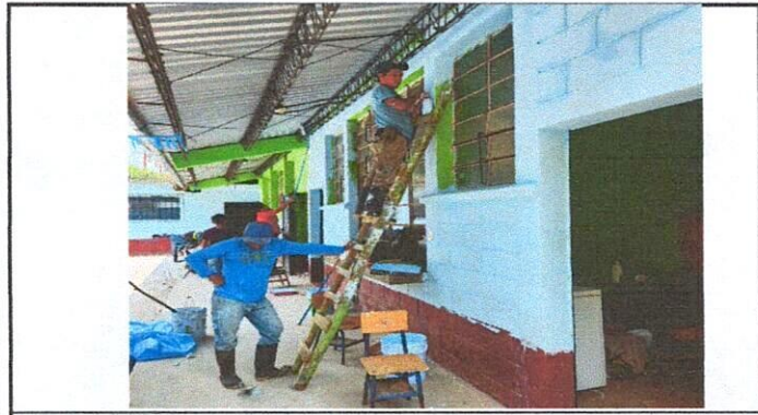
Foto 3: PINTURAS EN MUROS EXTERIORES E INTERIORES
