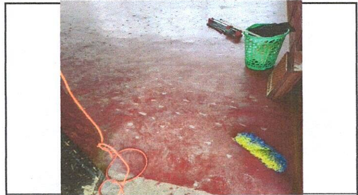
Foto 2: SUSTITUCION DE PISO DE CEMENTO POR AZULEJO
