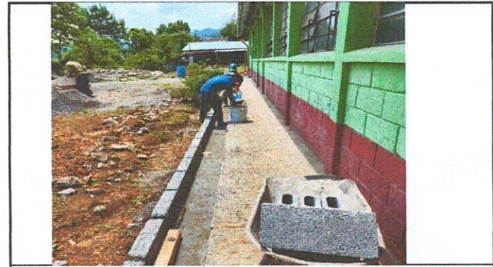
Foto 4: CUNETAS DE CONCRETO
